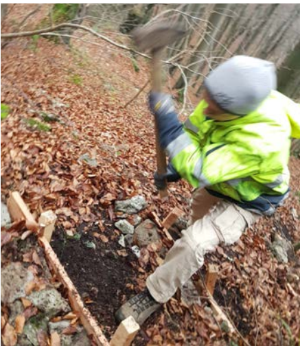
Neue Wege entstehen
